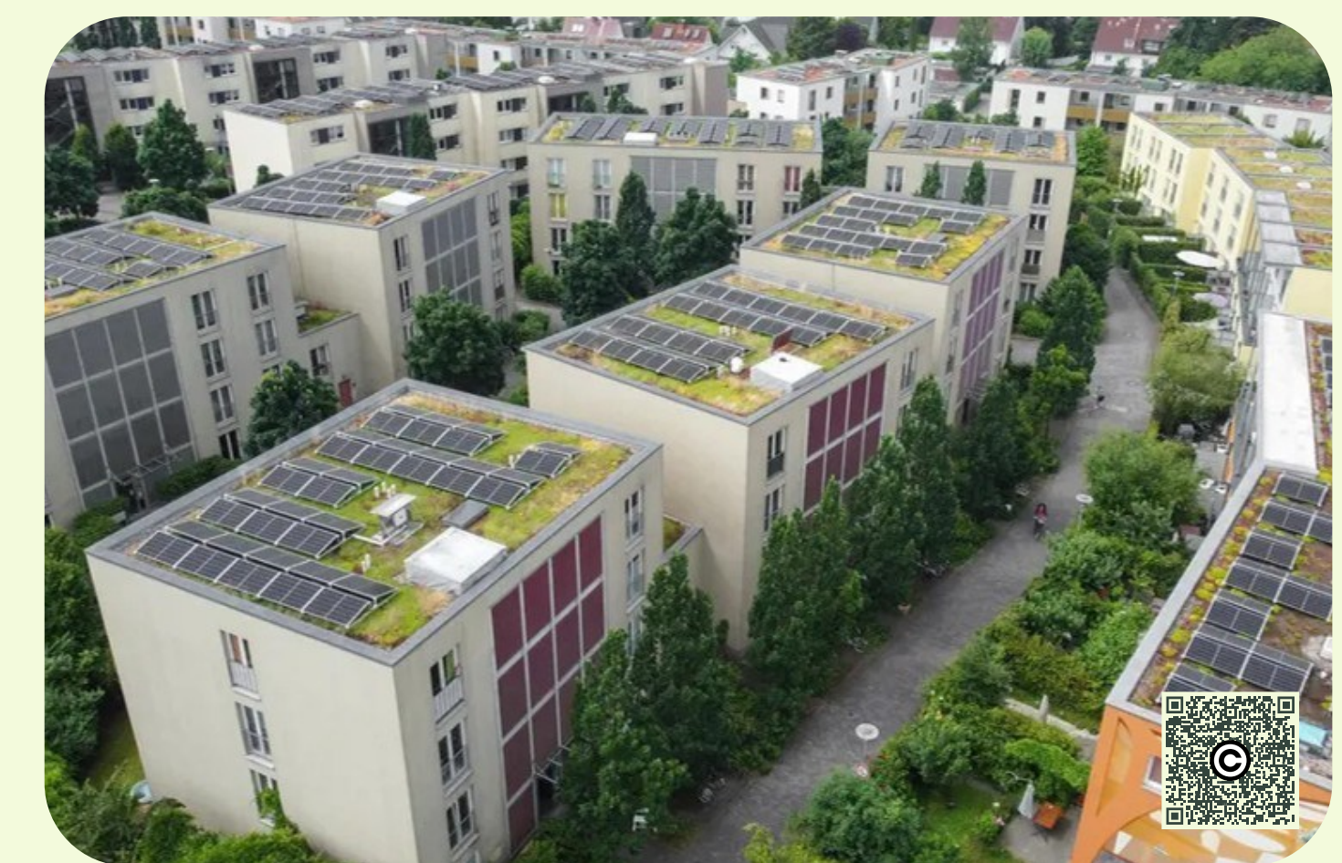
PV-Anlagen auf den Dächern der Siedlung
